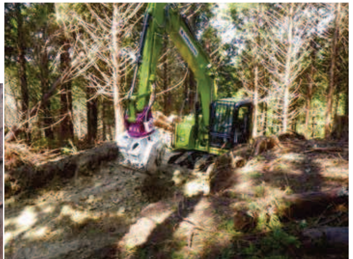
フェラーバンチャ作業道作設中
