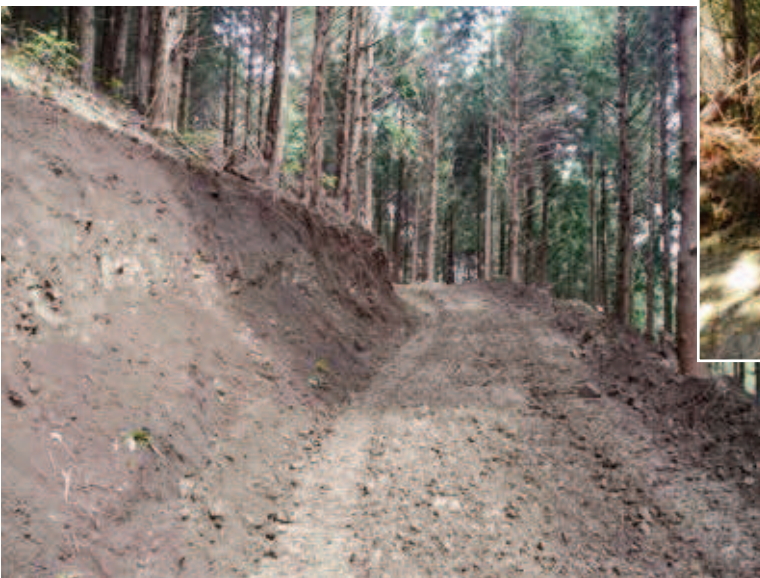
完成した作業道
