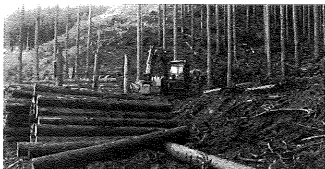
施業地近辺に中間土場を確保、工場への直送体制の充実
